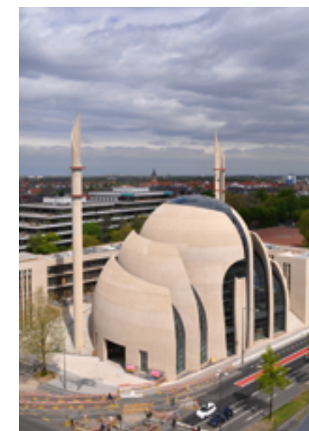
In der Formsprache schlicht und einprägsam, ist der Bau in der äußeren und inneren Gestaltung eine Entwicklung von der Tradition hin zur Moderne. Aufnahme: 11/2011
