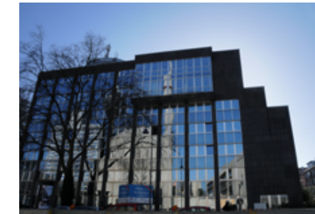
Abb. oben: Abrissarbeiten 2008 Abb. mitte: Kran-Ansicht vom Kuppelsaal Abb. unten: Spiegelung in Gebäude gegenüber
